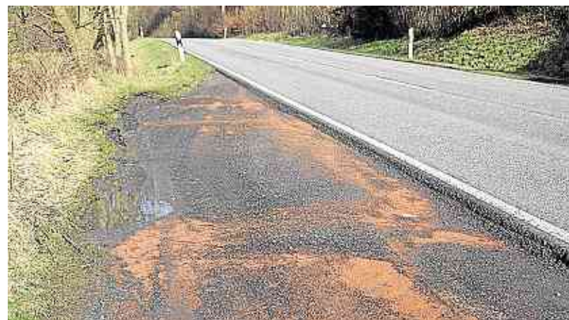
Was vom Unfall übrig blieb, hat Philipp Weigand im Foto dokumentiert: Reste von Bindemittel wurden offenbar vom Regen und dem vorbeiziehenden Verkehr an den Rand der L 285 zwischen Friedewald und Daaden gespült.
